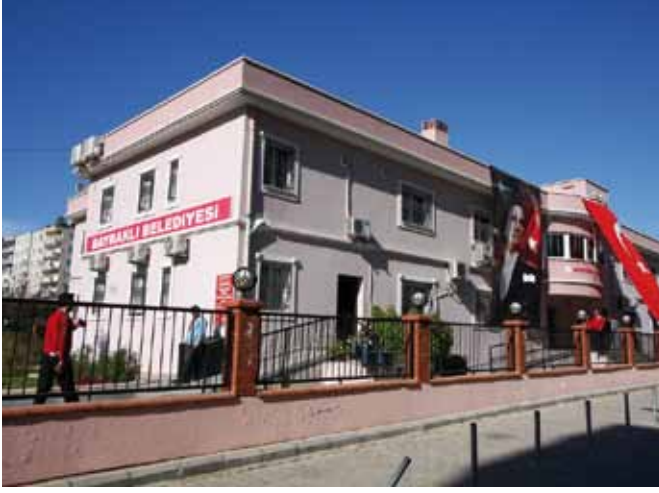
Manavkuyu Hizmet Binası
