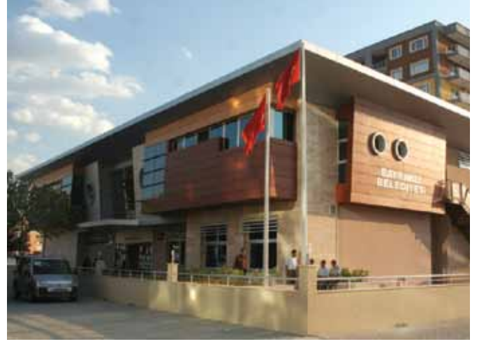
Osmangazi Hizmet Binası
