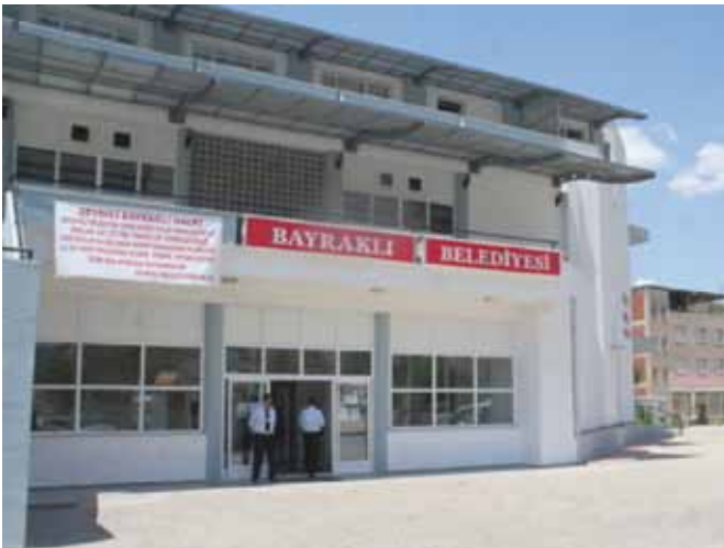
Postacılar Hizmet Binası
