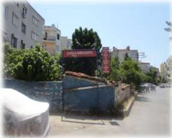
270 sokakta kamuya terkli alanda yapılan yapıların yıkılması.
