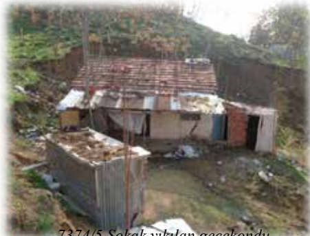
7374/5 Sokak yıkılan gecekondur
